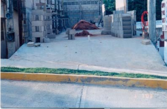
Construcción del Grupo
