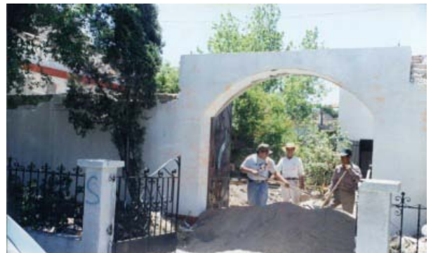
Trabajos en el Local Actual
